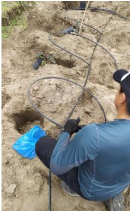
Figura 42. Instalación del sistema de fertirriego. Fuente: A. Rivera
