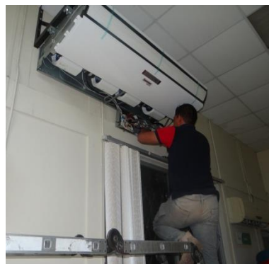
Fotografía 16-17. Instalación Aire Acondicionado
