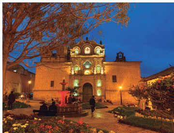
Iglesia Belén , Cajamarca. Edificada entre los años 1672 al 1774, integra el Conjunto Monumental Belén. Se ubica en la plazuela del mismo nombre, a una cuadra de la Plaza Mayor de la ciudad.
