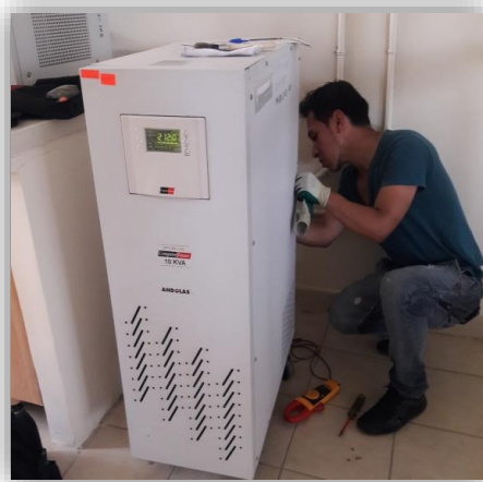
Fotografía 3-4 Verificación funcionamiento UPS's
