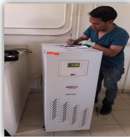
Fotografía 3-4 Verificación funcionamiento UPS's
