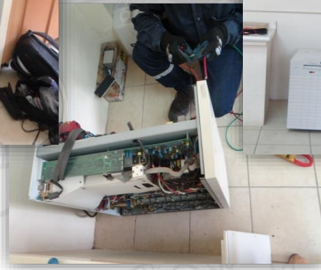
Fotografía 11-13 Verificación de UPS 6KVA, 10KVA
