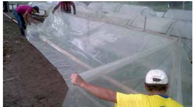
Foto 95. Cierre de cámaras de enraizamiento.
