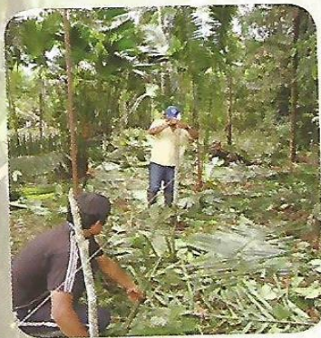
Foto 22. Colocación de balizas
