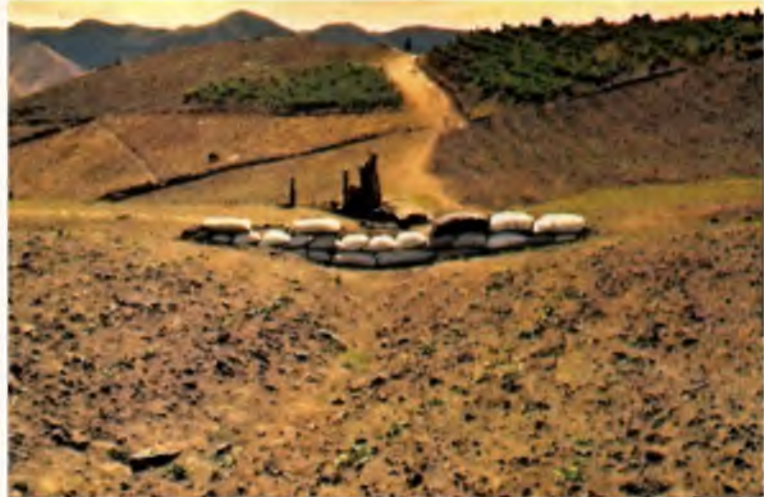
FOTO 46. Presa de sacos de yute rellenos con tierra.
