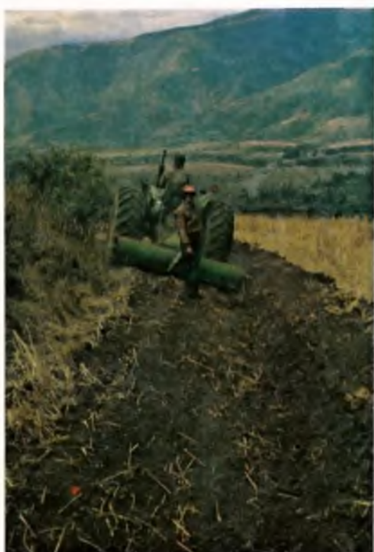
FOTO 39. Conformación de taludes utilizando tractor con hoja de nivelación en canales de desviación de agua.
