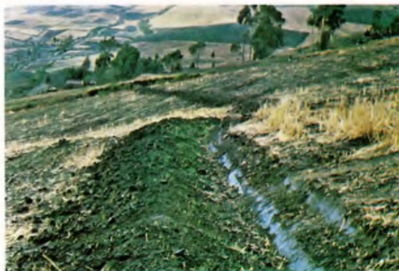
FOTO 40. Acondicionamiento definitivo de canales de desviación de agua.
