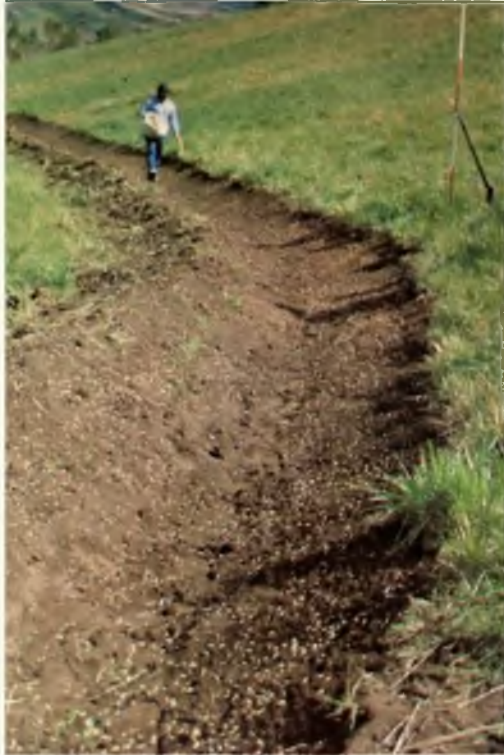
FOTO 41. Siembra de gramíneas para el revestimiento del canal.
