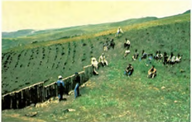
FOTO 44. Presa de palos acomodados en sentido vertical, con vertedor central.
