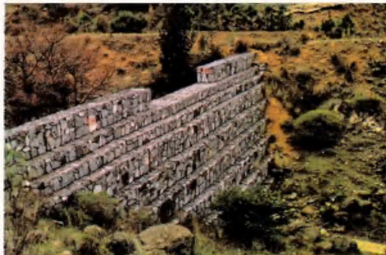
FOTO 48. Presa de gaviones.
