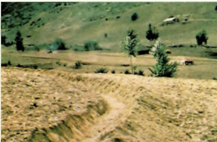
FOTO 37. Canal construido en forma manual.
