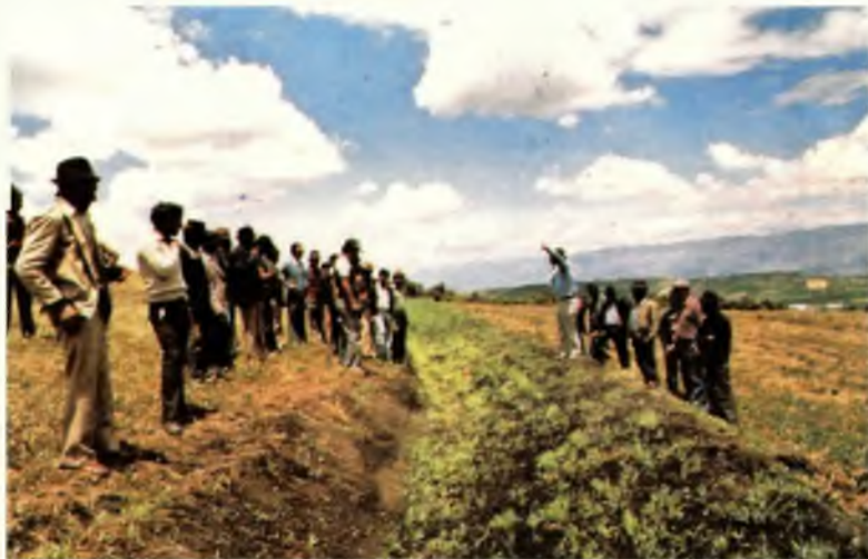
FOTO 42. Canal de desviación revestido con pastos.
