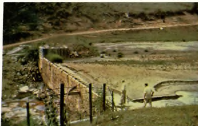
FOTO 12. Taponamiento de represas por acumulación de sedimentos.
