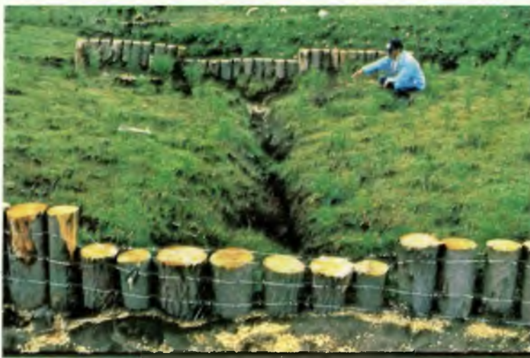
FOTO 45. Estabilización de presas de palos acomodados.
