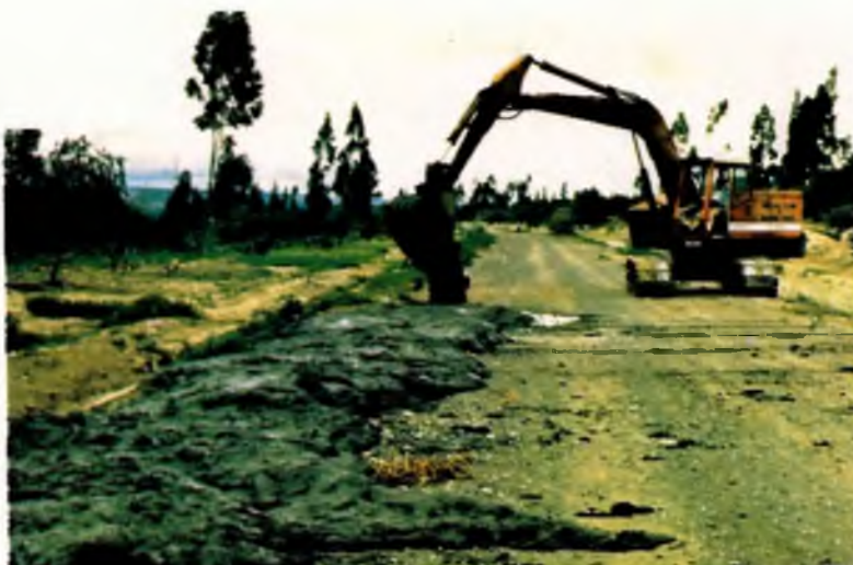
FOTO 13. Dragado de materiales depositados en canales de riego.
