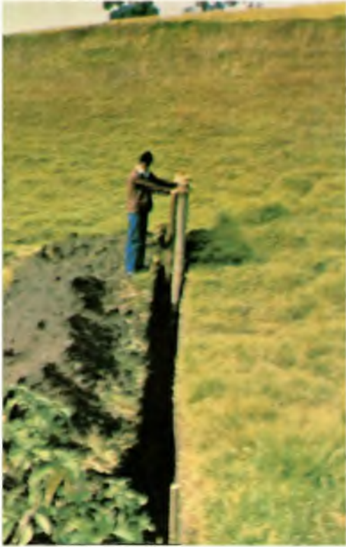
FOTO 43. Diseño y construcción de presa de palos acomodados en sentido vertical, con vertedor central.
