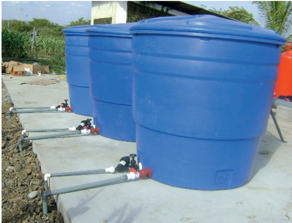
Figura 6. Tanques para disolver los fertilizantes.
