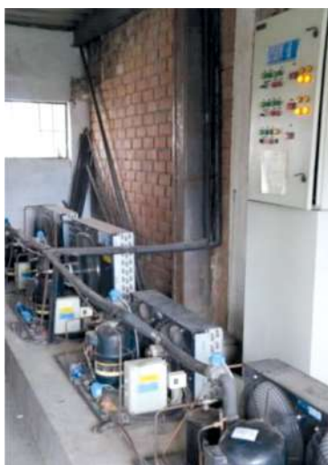
Figura 53. Compresores alternos para la conservación de semillas ortodoxas INIAP-DENAREF-EESC, 2025.
