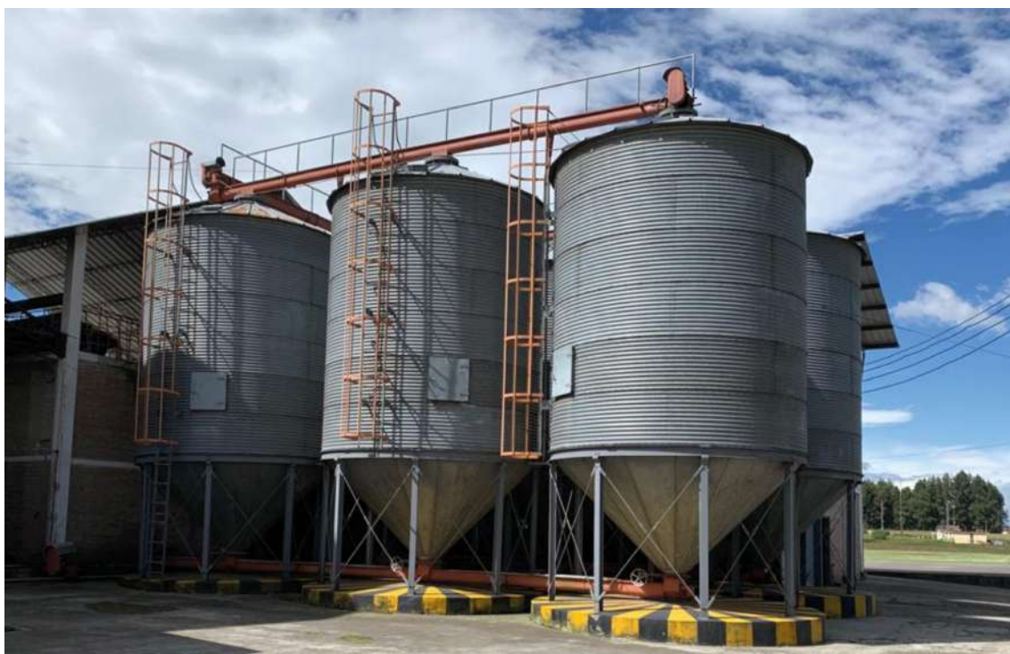
Figura 44. Silos metálicos para almacenamiento de granos capacidad 60 toneladas. INIAP-EESC, 2025.
