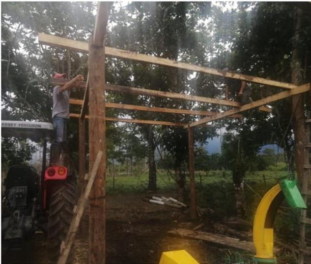
**Foto 3.** Construcción de garaje para maquinaria y tractor agrícola de la GED.
