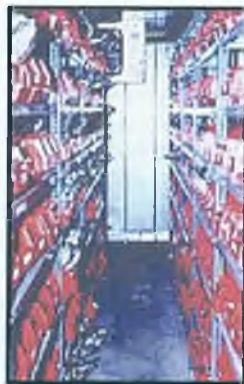
Figura 45. Banco base con temperatura constante de -15^{\circ}\text{C} en donde se conservan semillas ortodoxas de varias especies en fundas herméticas de aluminio plastificado. INIAP, 2008.
