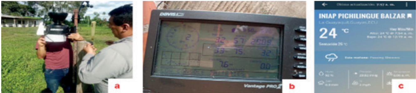
Figura 2. a) Instalación de la estación meteorológica portátil, b) datos en la consola y c) funcionamiento de la plataforma Davis.
