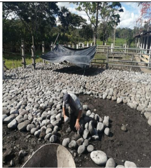
Adecuación del corral bovino de la GED.
