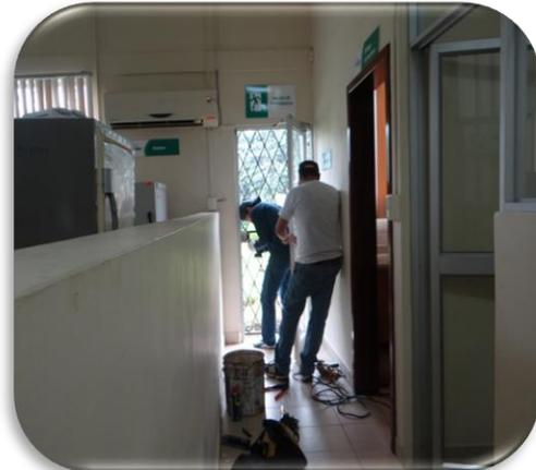
**Fotografía 1-2.** Cambio de cerradura salida de emergencia
