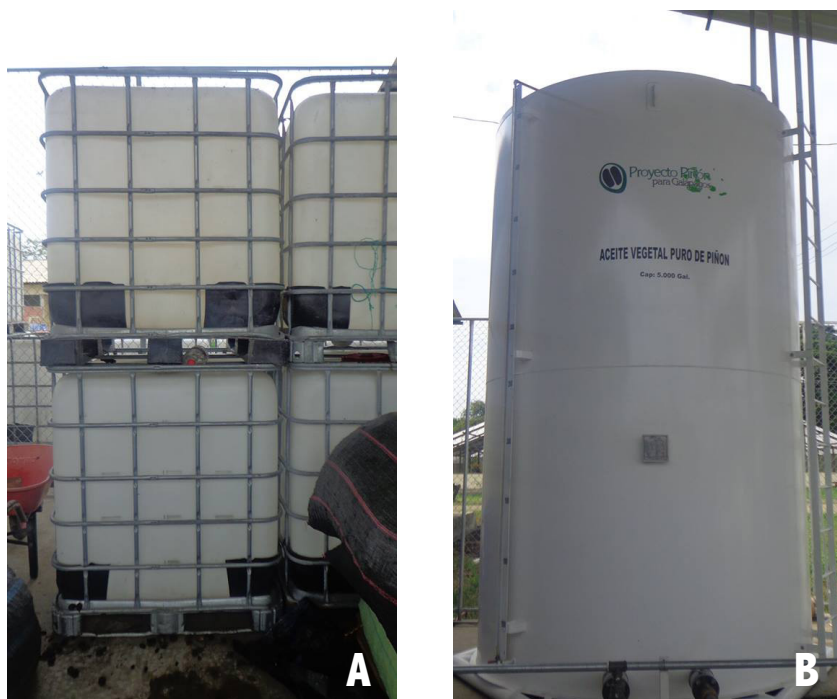
Figura 14. (a) Tanques de almacenamiento en “tote” y (b) tanque de acero inoxidable.
