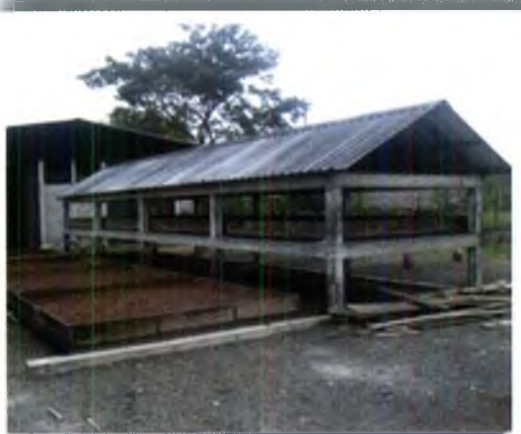
Tendal corredizo con cubierta
