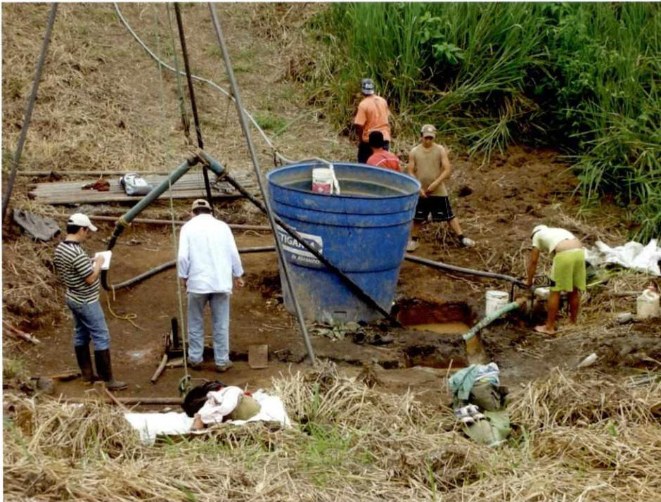
Foto 42. Proceso de construcción de un pozo de 40 metros de profundidad para riego al costado de un drenaje natural en la zona de Quevedo
