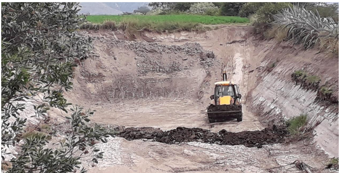
Foto 2. Limpieza de estanque almacenador de agua para riego. Granja Yachay
